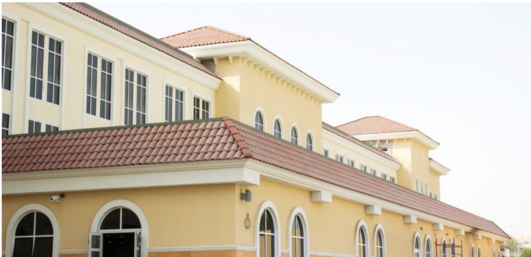
Το Μακεδονίτικο κεραμίδι της ΚΕΒΕ χρησιμοποιήθηκε στο σχολείο Baniyas στο Dubai.
